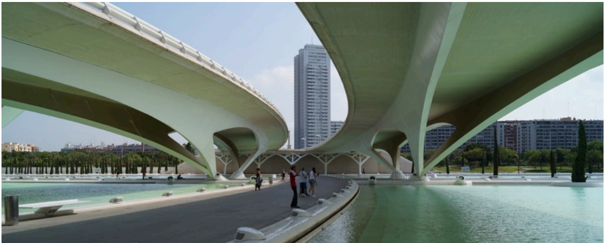
Abbildung 20: Puente de Montolivet, Valencia
