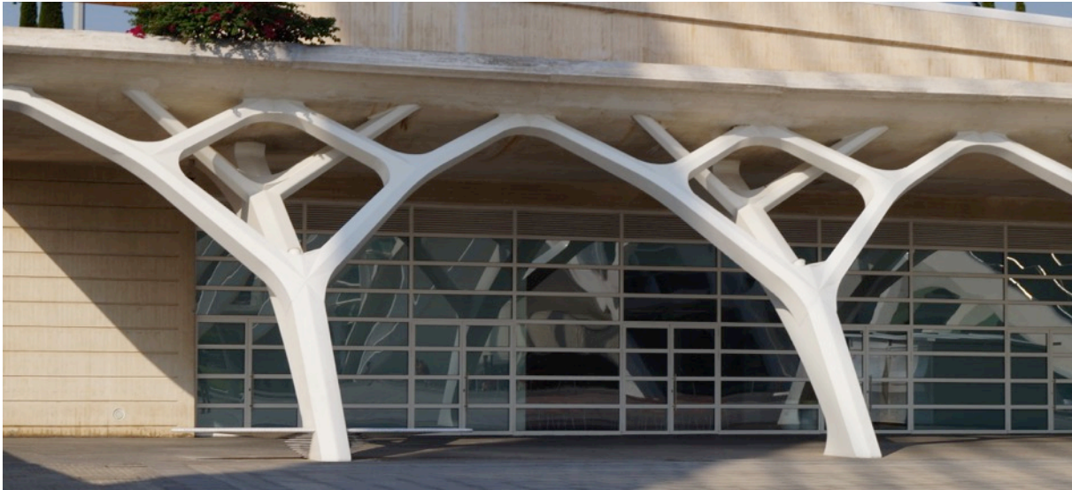
Abbildung 33: Unterbau des Umbracle, Valencia
